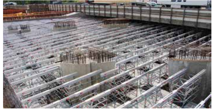
Tamamen monte edilmiş ve kalibre edilmiş destek sistemi
