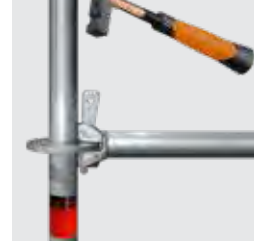
Bağlantıyı sağlamak için kamaya çekiçle vurun (500 g bir çekiç ile darbe sekmesi oluşana kadar).
