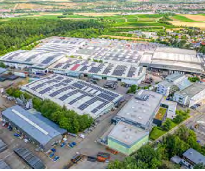
Eibensbach Merkez Tesisi
