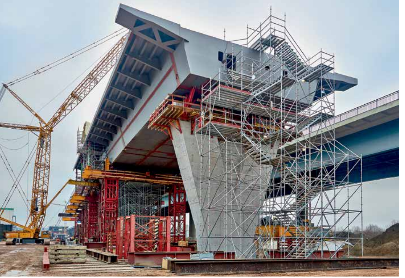
Üst: Temel erişim ve kaçış yolu olarak ve köprü inşaat şantiyesinde hacimli iskeleye entegre inşaat merdiven kulesi. Alt: Bireysel ve bağımsız merdiven kuleleri (Allround modüler merdiven kulesi ve inşaat merdiven kulesi 200).
